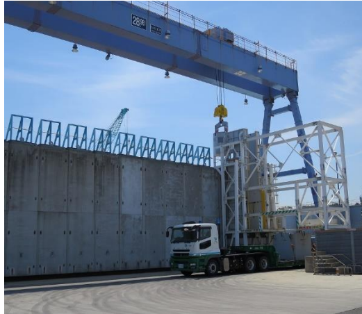
(第三施設北面 吊上げシャフト外観)
