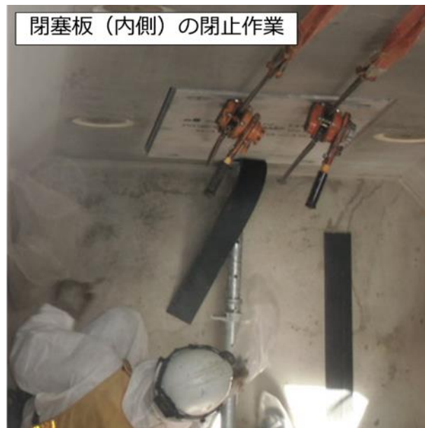
図 2.14.1-5 閉塞板による閉止状況
