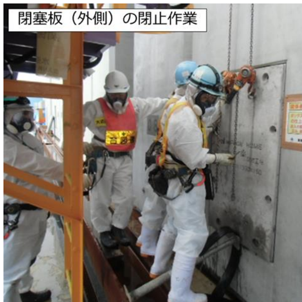
図 2.14.1-5 閉塞板による閉止状況
