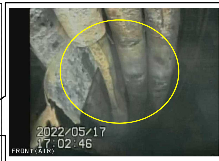
写真2. D/W内配管の状況
