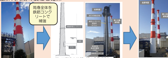
工事前 (R2.3月撮影) 工事途中外観 (R4.5月撮影) 補強完了 (R5.1月撮影) 工事実績：R3.7月～R5.3月
