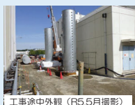
工事途中外観 (R5.5月撮影) 工事実績：R3.9月～
