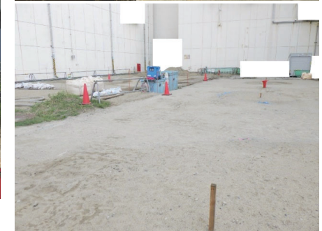
地盤改良後(R4年7月撮影)
