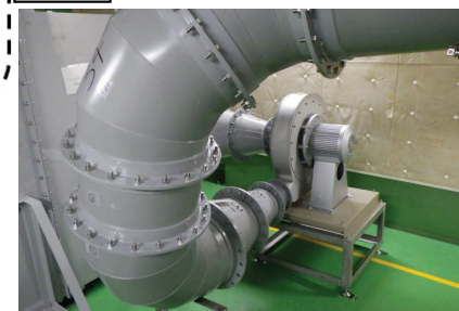
可搬型換気設備の設置時の様子
