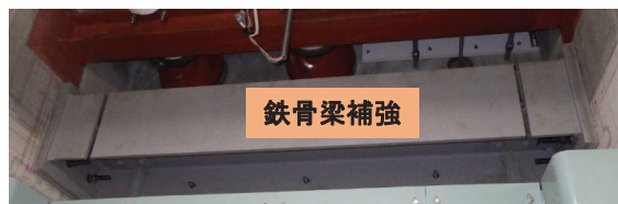
鉄骨梁補強箇所(天井パネル内)
