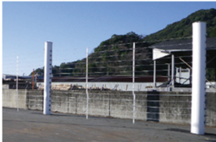
津波漂流物防護柵の設置イメージ
