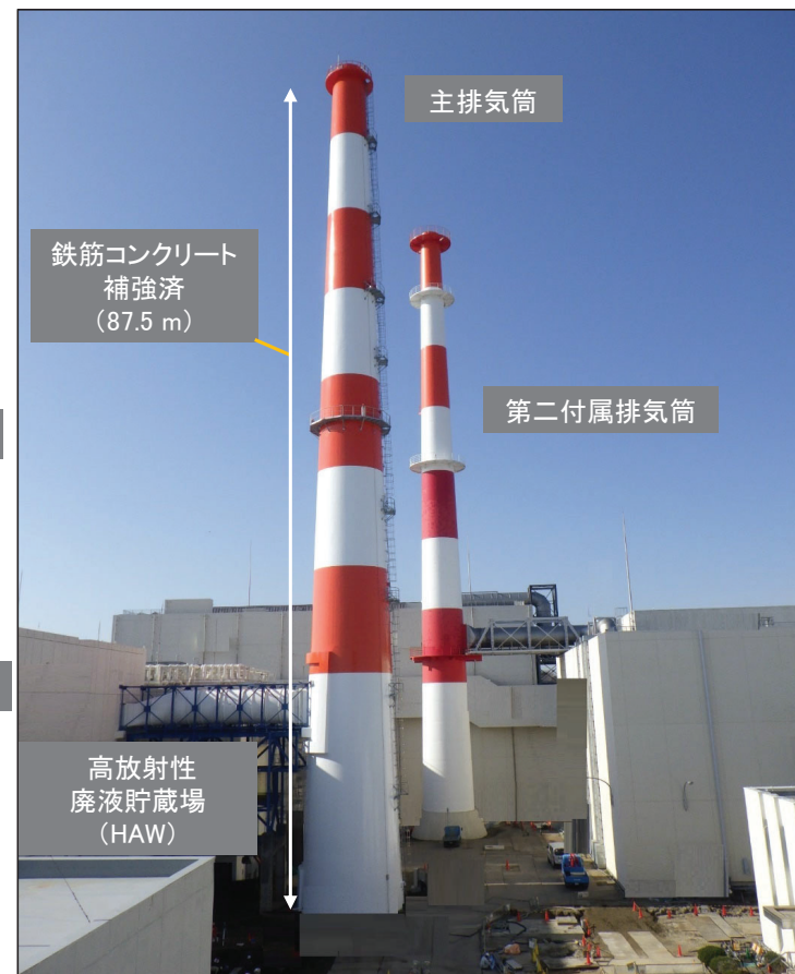
主排気筒の筒身補強工事の状況 < 9 > (令和5年3月)
