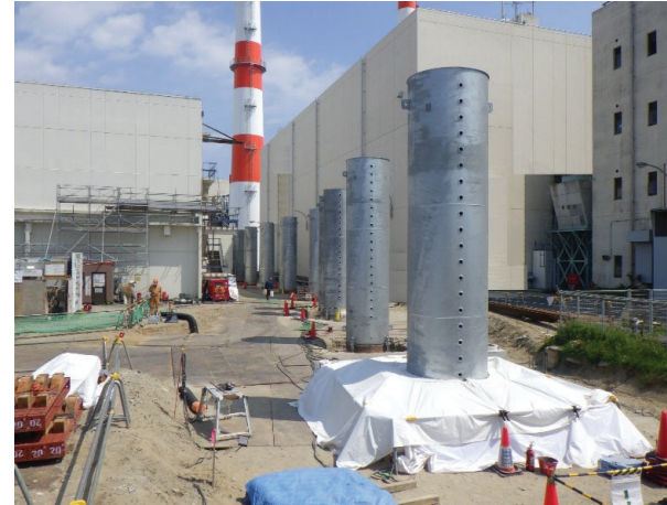
支柱建込(R5年5月撮影)
