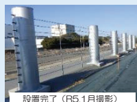
設置完了 (R5.1月撮影) 工事実績：R4.5月～R5.1月
