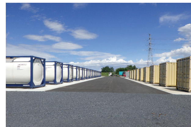
①: 事故対処設備保管場所(南東地区)
