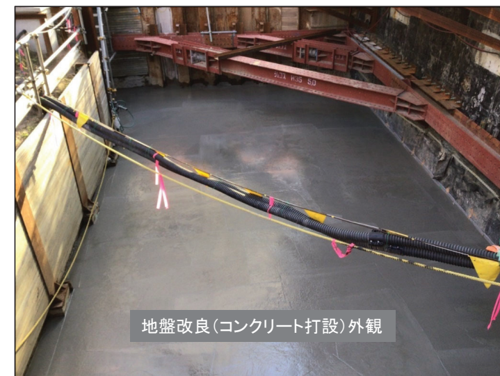
地盤改良工事の状況(令和3年12月)
