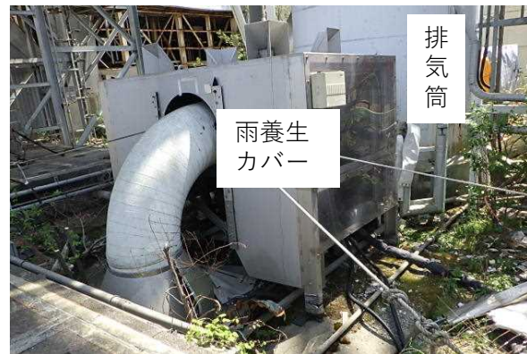
排気筒サンプ周辺状況
