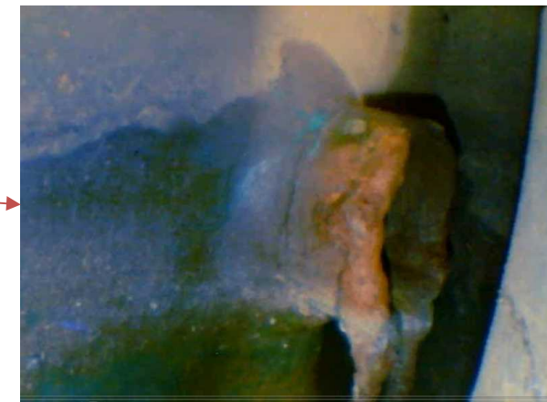
ピット南東側壁に確認された配管（散水前）
