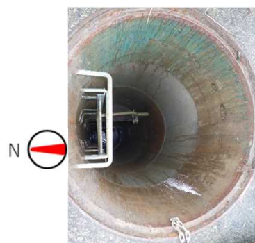
水面はマンホール上部から5m以上、下部にある（目測）
