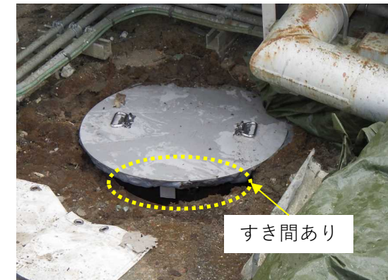
サンプ南東部のマンホール
