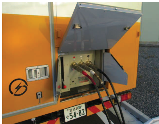
電源車ケーブル接続
