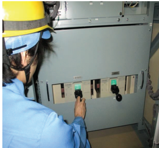
125V 代替蓄電池の切操作
