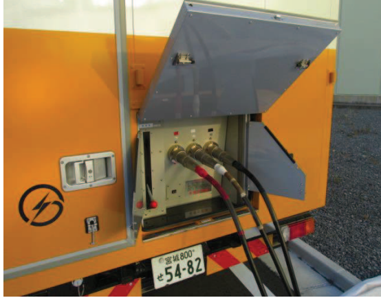
電源車ケーブル接続
