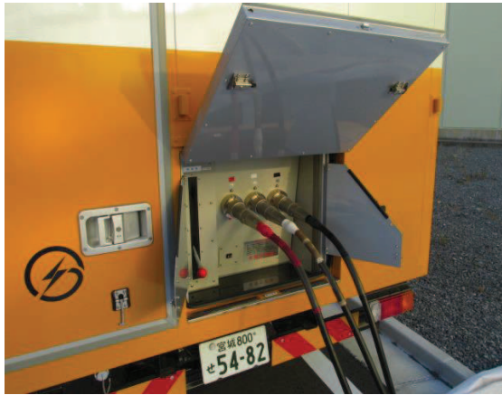
電源車ケーブル接続
