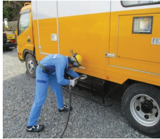
電源車への補給
