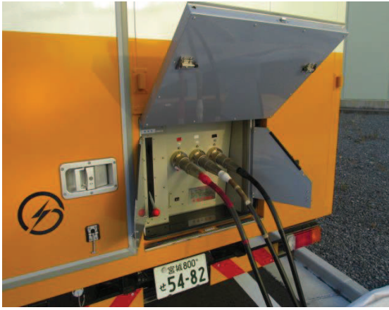
電源車ケーブル接続
