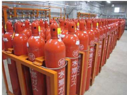
2号炉発電機ガスボンベ庫
