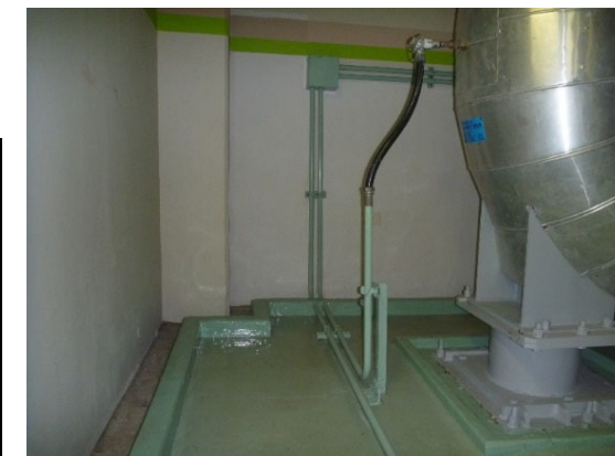
タービン建屋 内壁及び床
