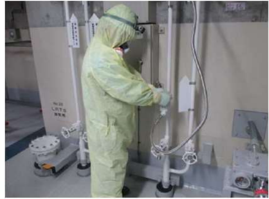
(制御用空気供給弁閉操作イメージ)
