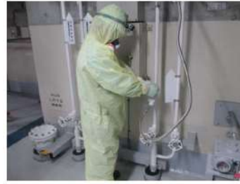
(制御用空気供給弁閉操作イメージ)
