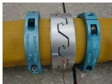
可搬型ホース（150A）接続後
