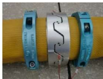
可搬型ホース（150A）接続後
