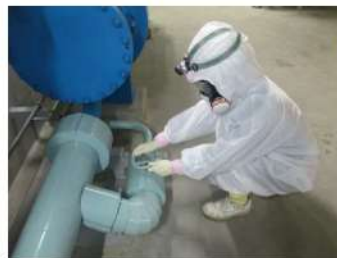
原子炉補機冷却海水系水抜き (ディーゼル発電機建屋 T.P. 6.2m)
