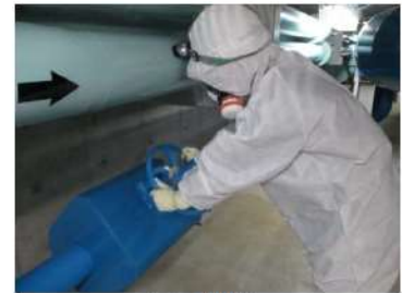
通水操作 (周辺補機棟 T.P. 2.3m)
