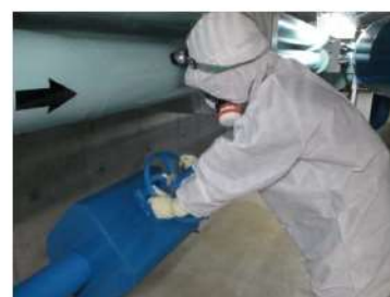
通水操作 (周辺補機棟 T. P. 2. 3m)
