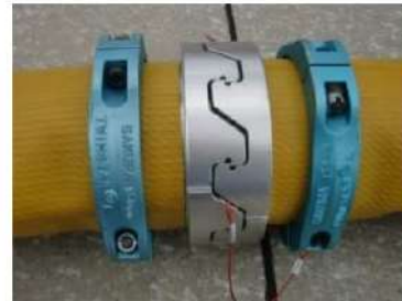
可搬型ホース(150A)接続後
