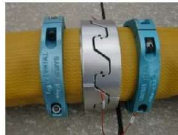
可搬型ホース(150A)接続後
