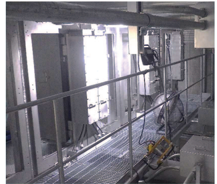
原子炉建屋ブローアウトパネル閉止装置写真
