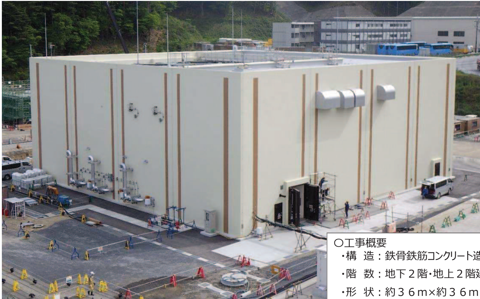
緊急時対策建屋
