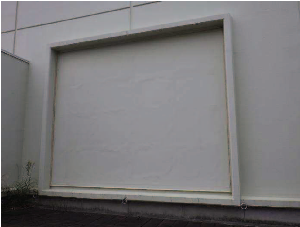
原子炉建屋ブローアウトパネル(外面)
