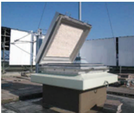
原子炉建屋ベント装置（開放状態）
