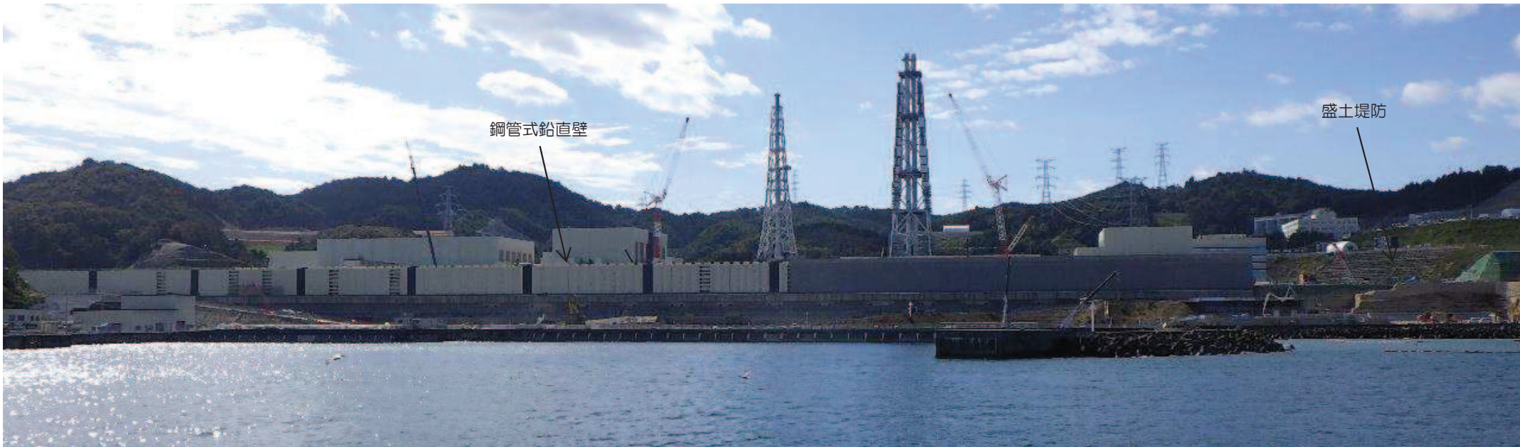
防潮堤全景(対岸より撮影)
