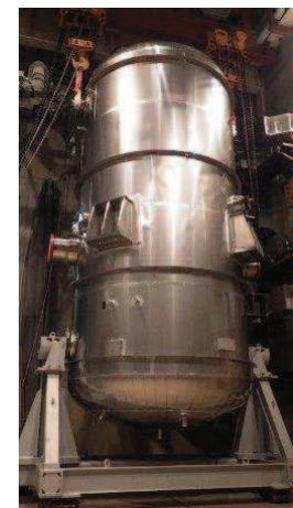
フィルタ装置(C)据付作業状況
