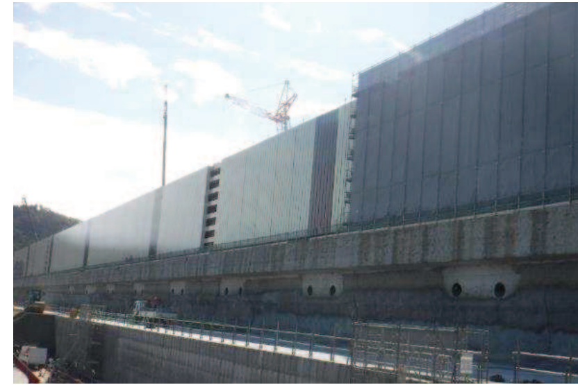
防潮堤(鋼管式鉛直壁)
