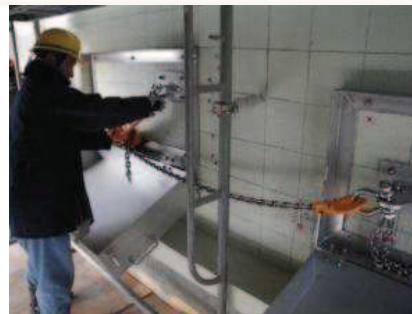
手動開放装置（レバブロック）操作
