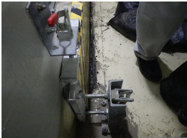
堰本体及び堰の取付け部 (外観上有害な傷なし)
