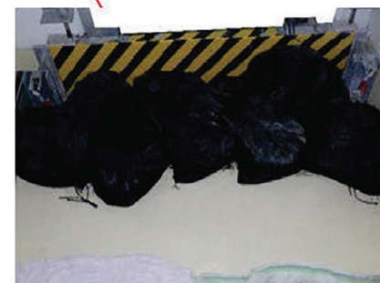
土嚢の設置状況
