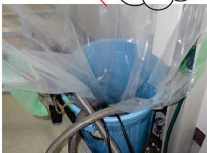
雨水の集水状況
