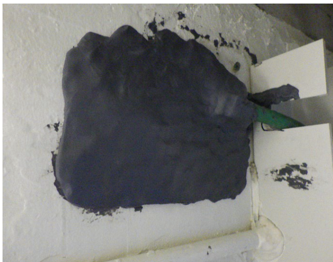
追加の止水材取付け
