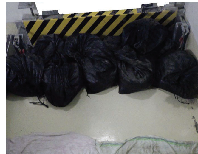
堰部に土嚢設置
