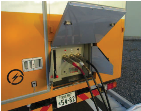
電源車ケーブル接続
