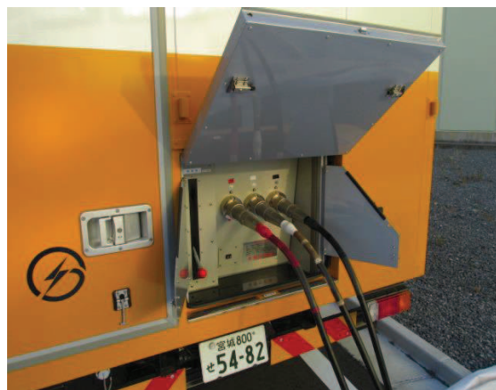
電源車ケーブル接続
