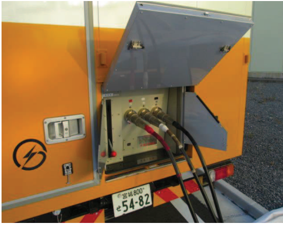
電源車ケーブル接続
