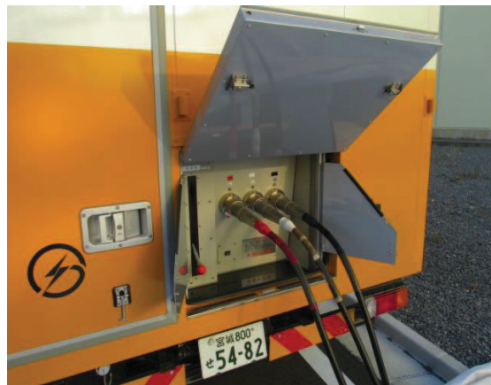
電源車ケーブル接続
