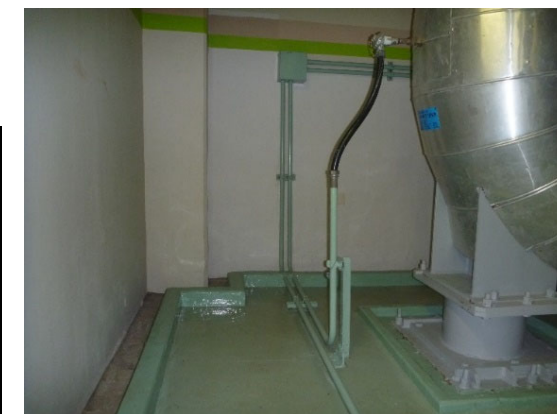
タービン建屋 内壁及び床
