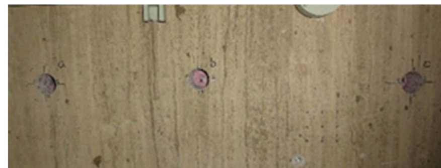
中性化の点検状況
