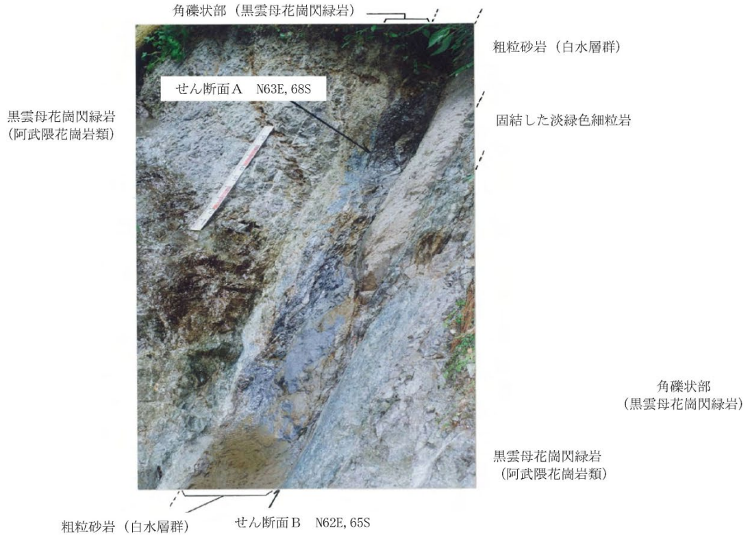
写真1 露頭傾斜部全景
