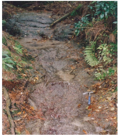
写真1 リニアメント延長位置の健岩の露頭状況
