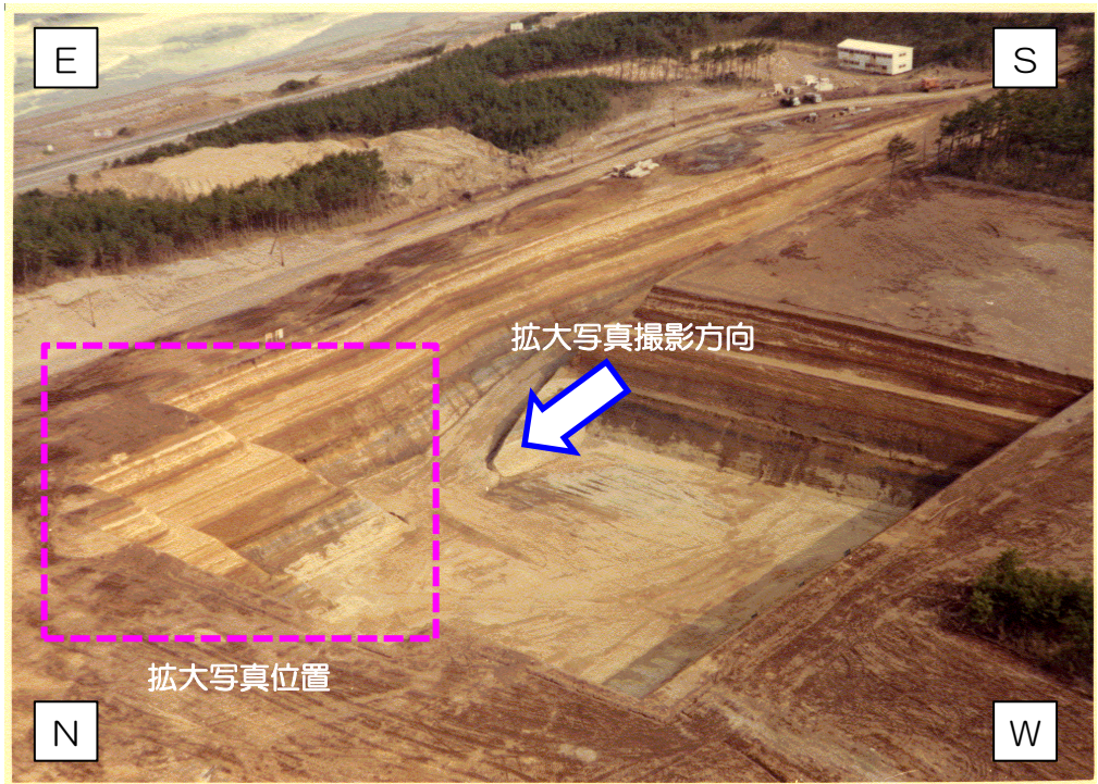
建設工事の掘削状況写真（1970年（昭和45年）4月）
