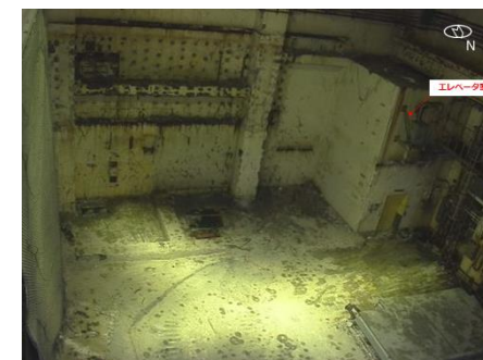
FHM操作室解体後
