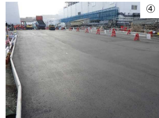
3号機側から4号機側を臨む。 (2023.1月末完了)
