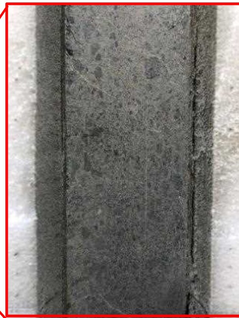
削孔開始から0.5m付近
