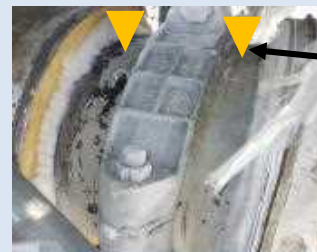
配管レベル計測箇所
