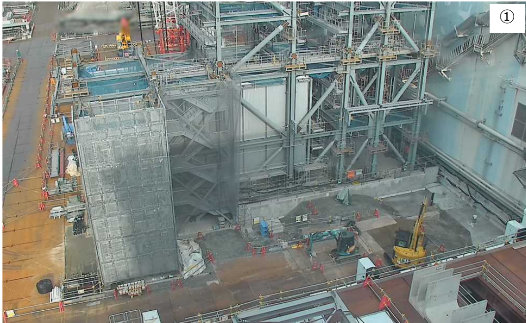
2号機燃料取り出し構台設置に合わせてフェーシング実施中
