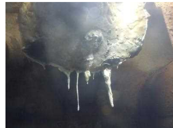
止水により地下水流入停止
