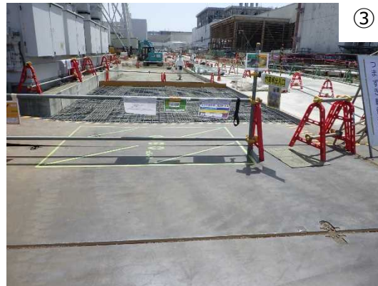
2号機側から3号機側を臨む。 (陸側遮水壁側から施工中)
