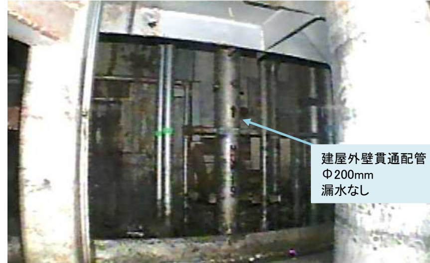
T.P.+1m~T.P.+3m付近：滞留水（過去）水没していた箇所
