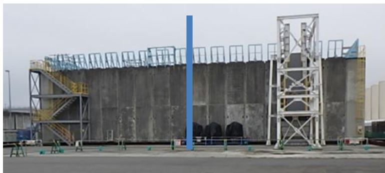
第三施設を北側から南側へ撮影した写真。中心線より右が西側・左が東側。
