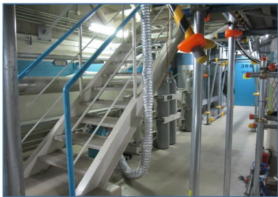
原子炉周辺建屋 E.L. + 17.1m
