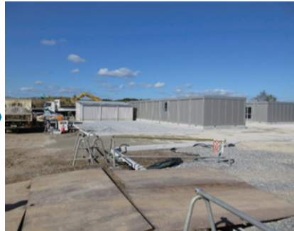
【建設地(海拔約30m)】
