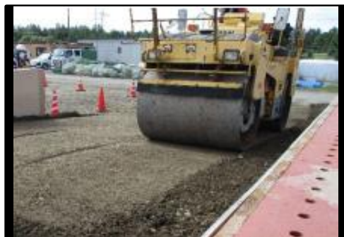
施工状況(予備試験)
