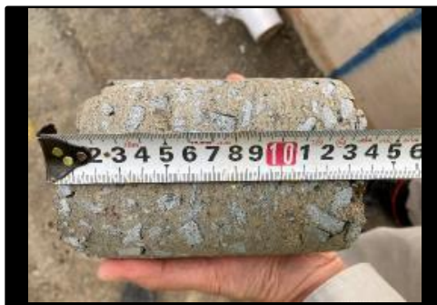
覆土材料(施工後コア)
