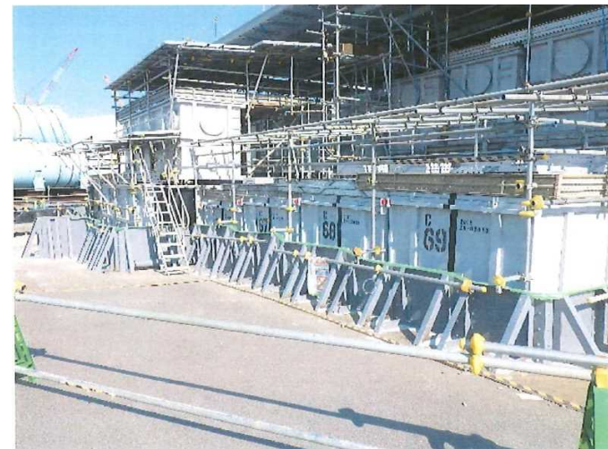
※1 屋根、足場、止水堰
