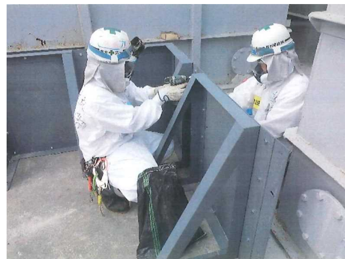
※4 止水堰の設置状態
