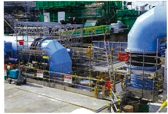
海水移送配管・海水配管ヘッド設置の状況
