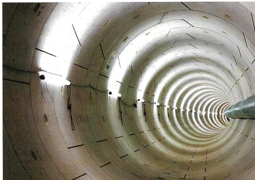
トンネル内部の状況
