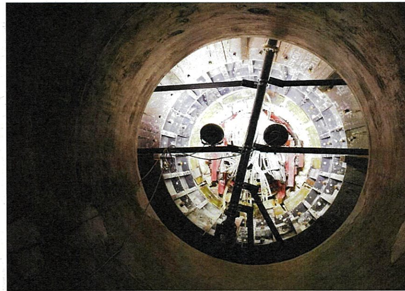
トンネル先端状況
