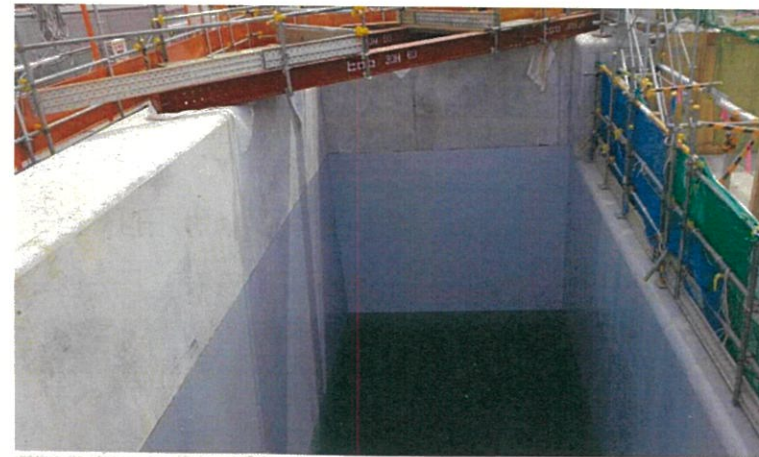
上流水槽 堰の構築状況
