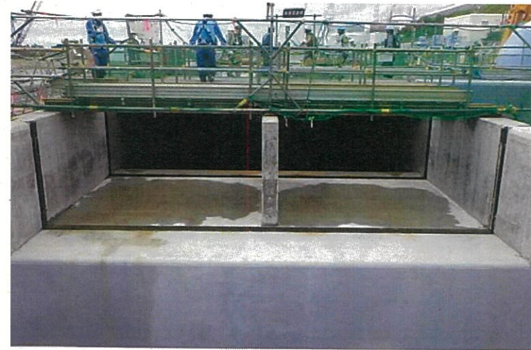
上流水槽 堰の構築状況
