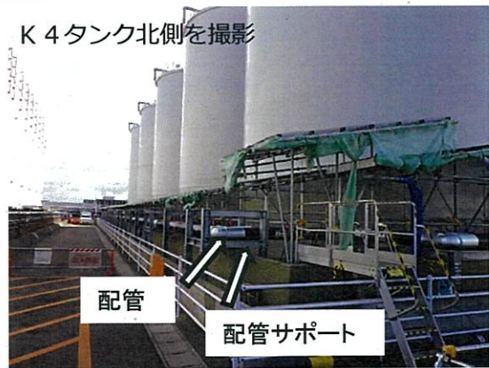
循環配管・サポート設置の状況
