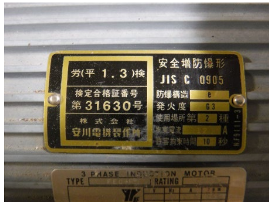
図1 防爆仕様の送液ポンプの例 (焼却施設(IF) のポンプ(342P211))
