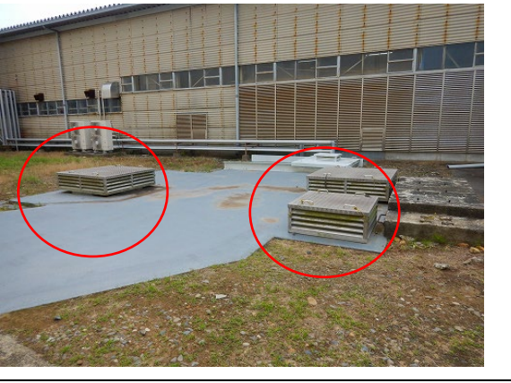
撮影方向⑥ B トレンチ出入口付近グレーチング
