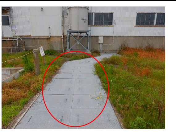
撮影方向② 二次冷却系統冷却塔跡地前グレーチング
