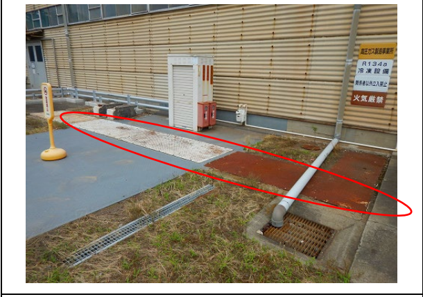
撮影方向③ 空気系統用冷却設備付近グレーチング
