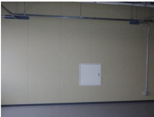
図 4-5 施工後の状況（窓側）
