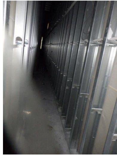
図 4-4 壁の内側の状況
