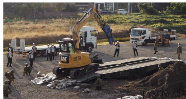
支援センター保有无線重機 通行可
