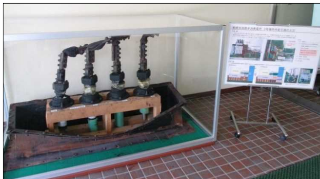
柏崎刈羽3号炉 所内変圧器の火災
