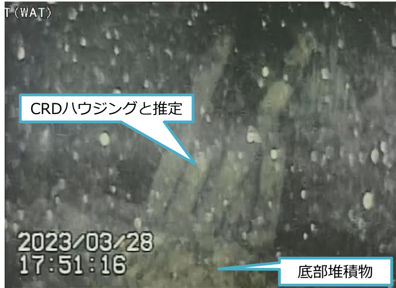
写真1. CRDハウジングと思われる構造物
