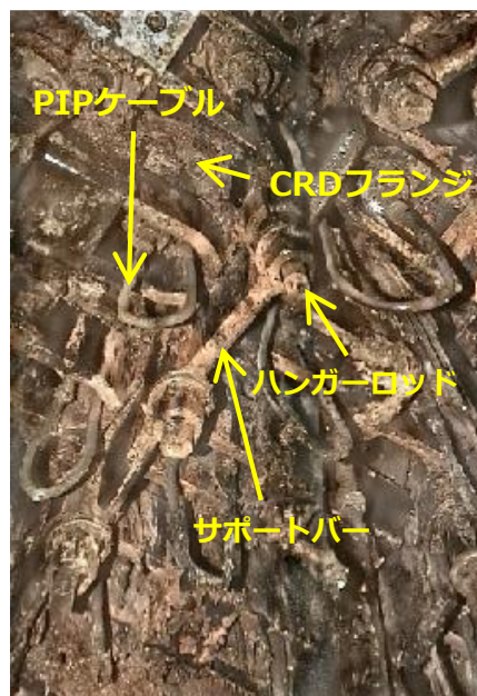
写真2. 2号機で確認されたCRD
