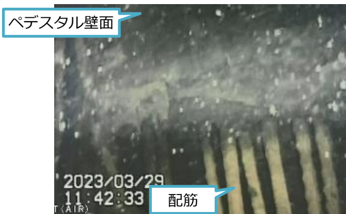
写真1. ポイント⑪ペDESTAL基礎部
