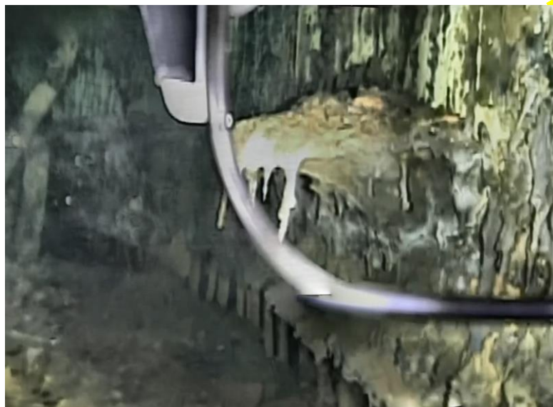
写真2 (パノラマ) 開口部右側の棚状堆積物
