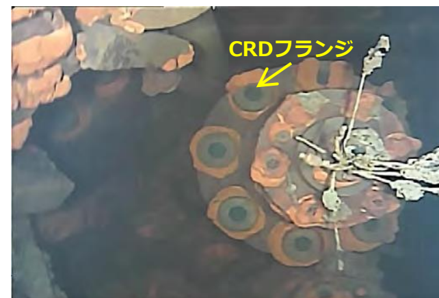
写真3. 3号機で確認されたCRD
