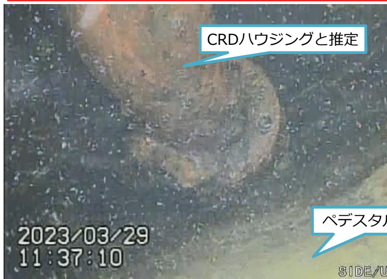
写真1. CRDハウジングと思われる構造物 (上部監視カメラで気中を撮影)
