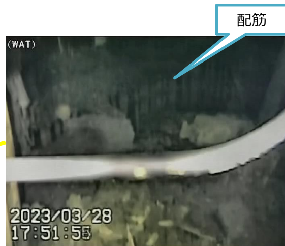
写真1. ポイント⑧ペDESTAL基礎部 画像処理：東京電力ホールディングス(株)
