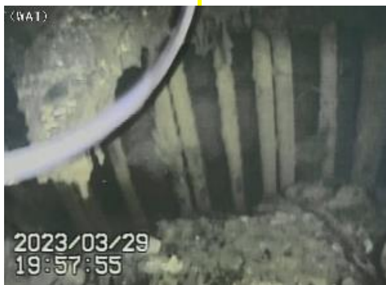
写真3 比較的に大きい棚状堆積物
