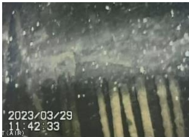
写真1. ポイント⑪上部
