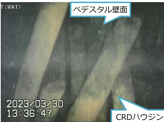
写真2. CRDハウジングと思われる構造物
