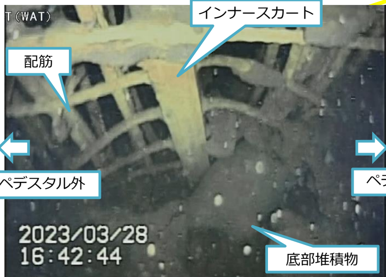
写真2.ペDESTAL開口左側配筋
