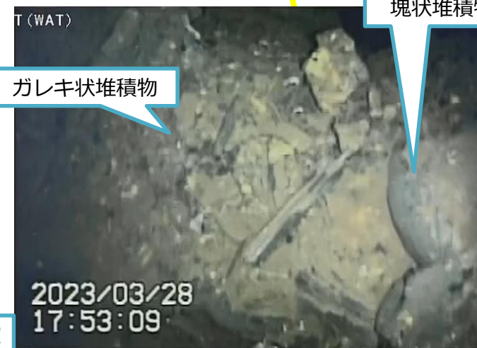
写真3.ペDESTAL内開口付近堆積物
