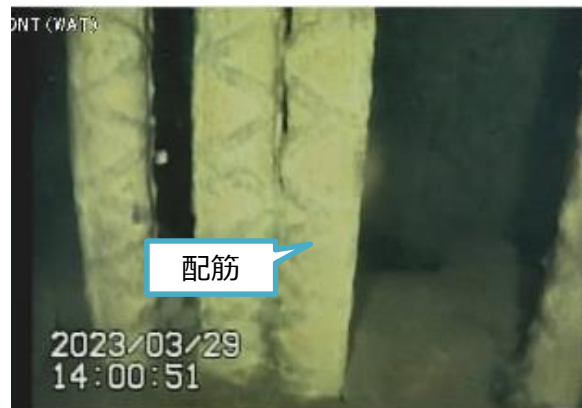
写真2. ポイント⑫ペDESTAL基礎部
