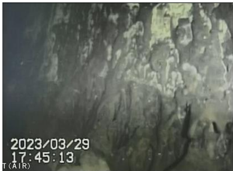
写真1 棚状堆積物のない壁面の状況
