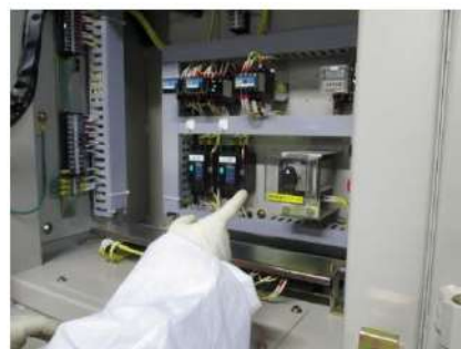
受電遮断器操作 (安全補機開閉器室) (原子炉補助建屋T. P. 10. 3m)
