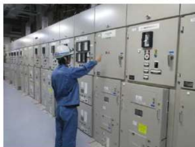
M/C 電源確認 (安全補機開閉器室) (原子炉補助建屋T. P. 10. 3m)
