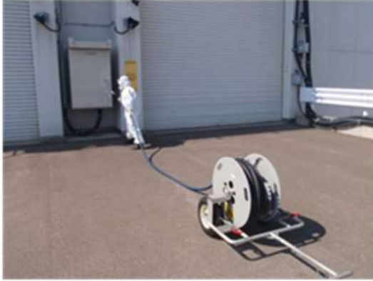
高圧ケーブル敷設 (屋外T. P. 31. 0m)
