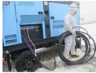
可搬型直流電源用発電機ケーブル敷設 (屋外 T.P. 31m)
