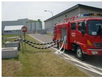
可搬型大型送水ポンプ車の設置 原水槽への吸管挿入 （屋外 T. P. 10. 3m）
