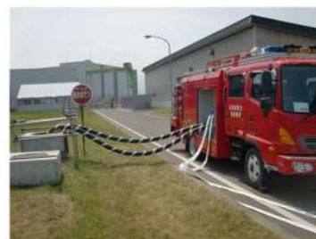
水源への吸管挿入 (屋外 T.P. 10.3m)
