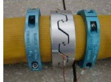
可搬型ホース (150A) 接続後
