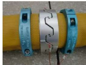
可搬型ホース（150A）接続後
