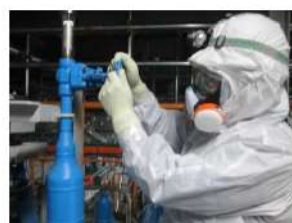
原子炉補機冷却水系加圧操作 (原子炉建屋 T. P. 46. 2m)
