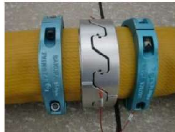
可搬型ホース（150A）接続後
