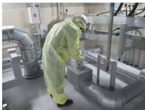
RHRS-CSS 連絡ライン手動弁操作 （原子炉補助建屋 T.P. 14. 5m）
