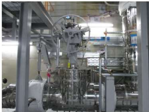
3 A-余熱除去ポンプ入口弁 (3V-RH-005A)
