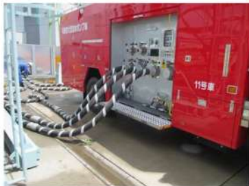
可搬型大型送水ポンプ車の設置 ポンプ車周辺のホース敷設 （屋外 T. P. 10. 3m）
