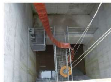
海水取水箇所への水中ポンプ設置 (屋外 T. P. 10. 3m)
