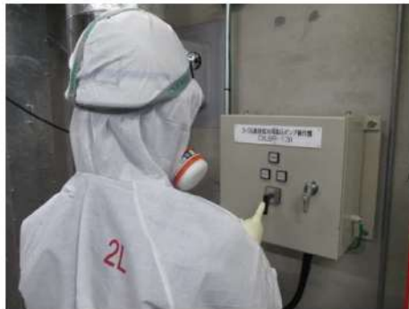
SG 直接給水用高圧ポンプ起動操作 (原子炉建屋 T. P. 24. 8m)
