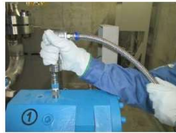
ホース接続操作（軸受側） （原子炉建屋 T. P. 10. 3m）
