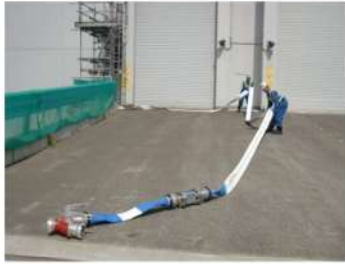
可搬型ホース運搬 (屋外 T. P. 33. 1m)
