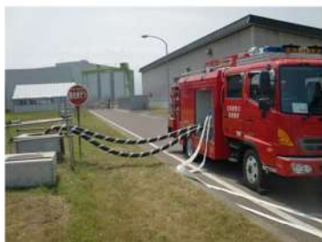
可搬型大型送水ポンプ車の設置 代替給水ピットへの吸管挿入 (屋外 T. P. 33. 1m) (作業風景は類似作業)
