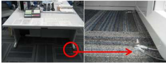
図10 運転員机の固定
