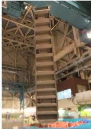
ゲート吊上げ作業 (写真は2号機)
