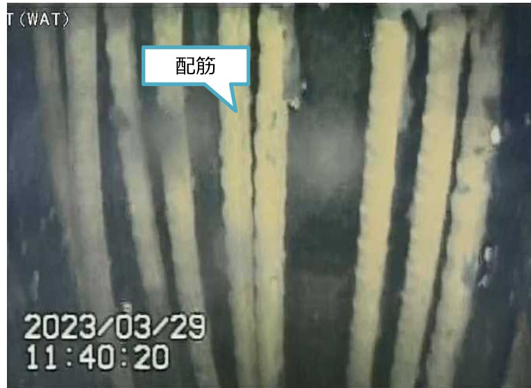
写真2.ペDESTAL内壁面部(下部)
