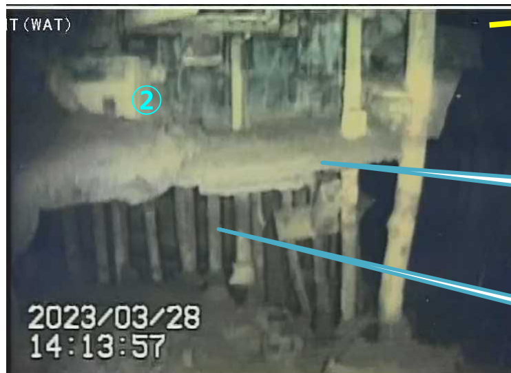
写真2.ペDESTAL開口部左下側壁面部
