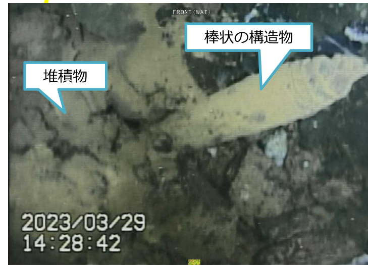
写真3.棒状の構造物(ペDESTAL底部)
