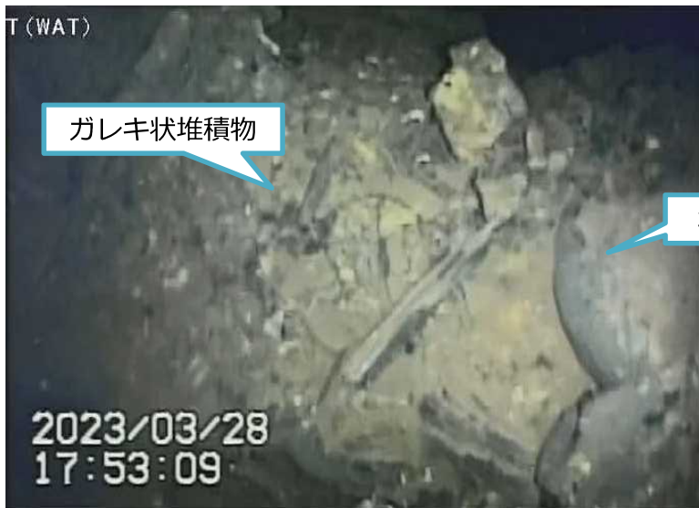
写真2.ペDESTAL内開口付近堆積物
