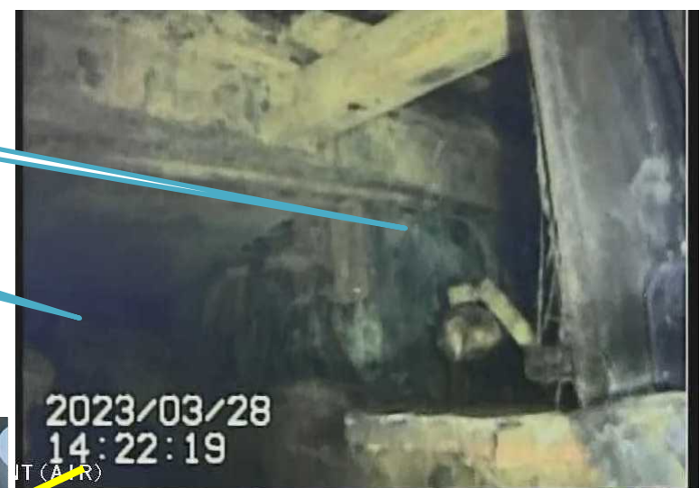
写真3.ペDESTAL開口部右上側壁面部
