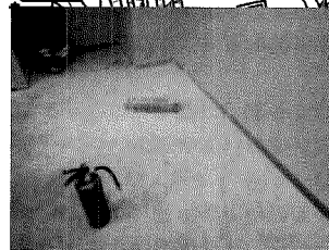
管理事務所2号館2階情報室 発煙したバッテリーの鎮火後の状況
