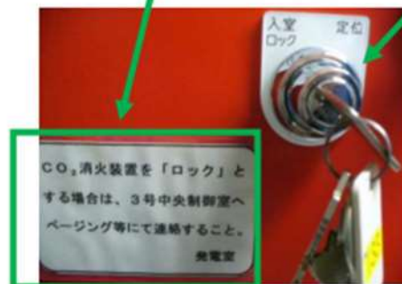
写真① 「入室ロック」とする際の中央制御室への連絡の表示
