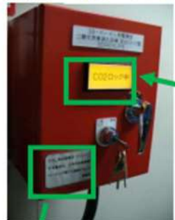
写真③ 放出ロック盤
