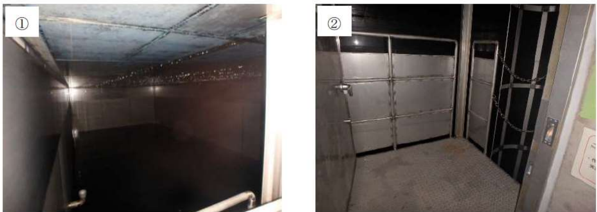
第 5-7 図：補助給水ピットの現場状況
