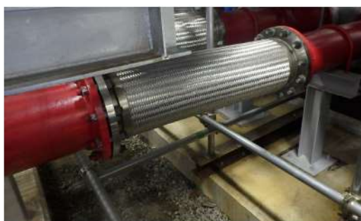
第 1-23 図：地震変位対策の実施例
