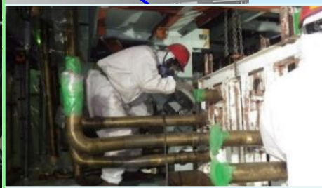
入口管の切断作業
