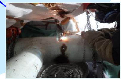
ECCS系配管の切断作業
