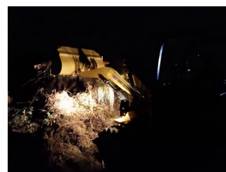
がれき撤去(夜間)
