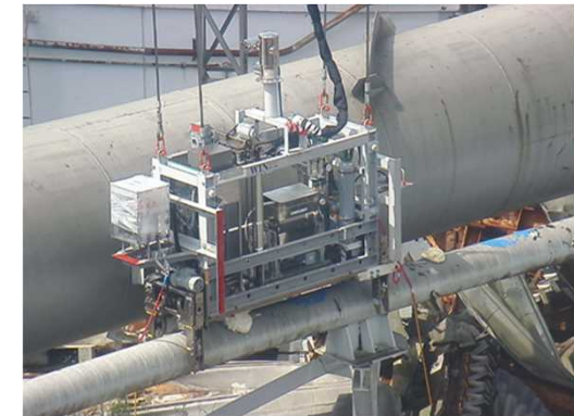
写真：2021年9月ウレタン注入時
