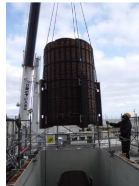
主変圧器・所内変圧器の解体撤去状況
