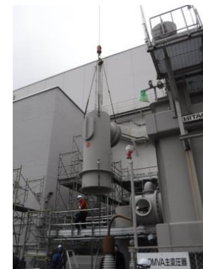
主変圧器・所内変圧器の解体撤去状況
