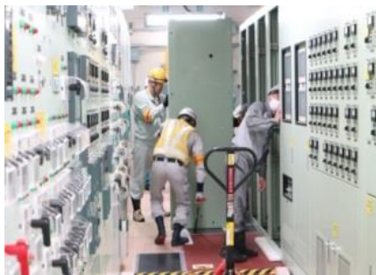
中央制御盤室制御盤の解体撤去状況
