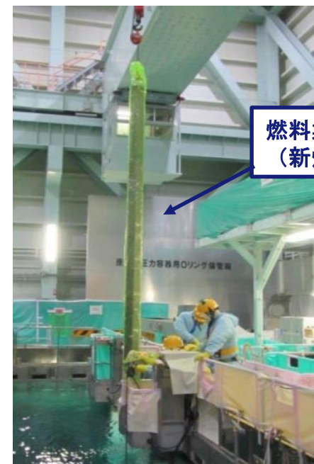
新燃料を燃料プールから 搬出している様子
