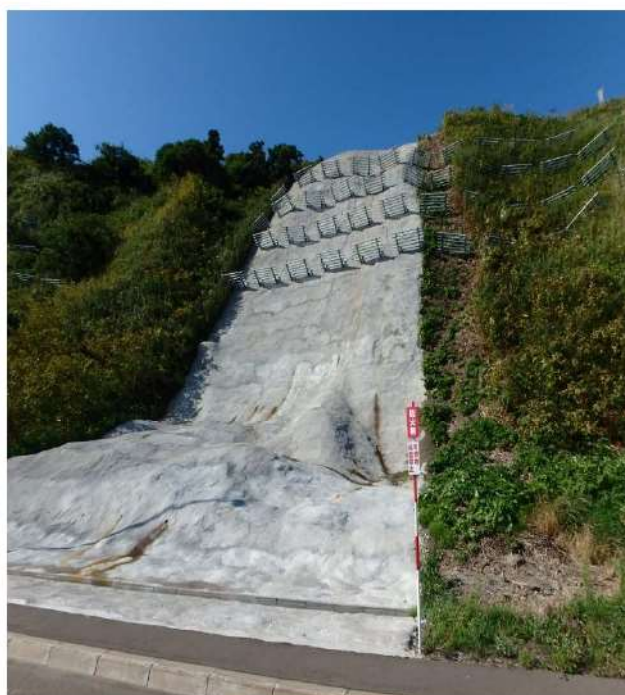
図1 防火帯モルタル吹付工の施工例
